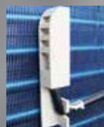
Sensores de temperatura en las serpentinas
